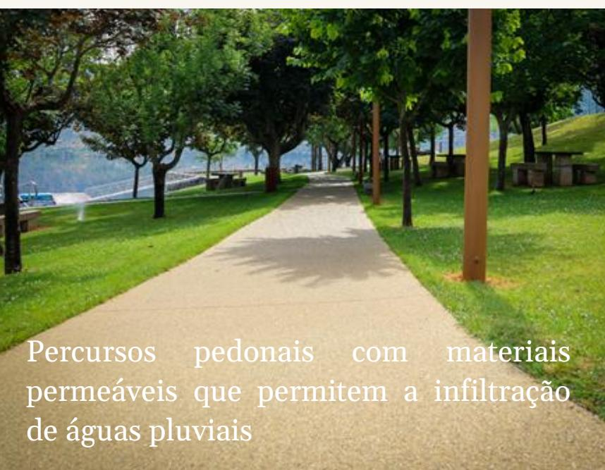
Percursos pedonais com materiais permeáveis que permitem a infiltração de águas pluviais
