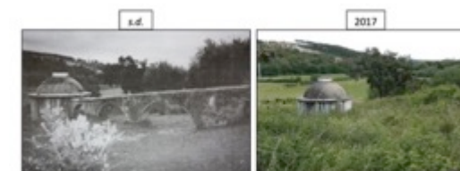
Figure 15a: Aqueduct Casal de Pal Poldro (Coelho, 1995)
